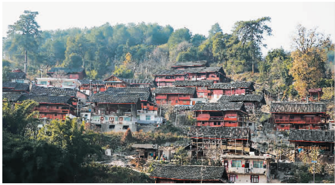
2017年起,贵州省黔东南苗族侗族自治州丹寨县实施对全县农村危房和附属的厨房、厕所、畜圈开展危房改造及改厨、改厕、改圈“三改”计划,切实帮助农村困难群众解决了厨厕分离、厕圈分离、人畜分离等基本的居住安全问题,保障了农村群众的卫生健康,改善了乡村的人居环境。
