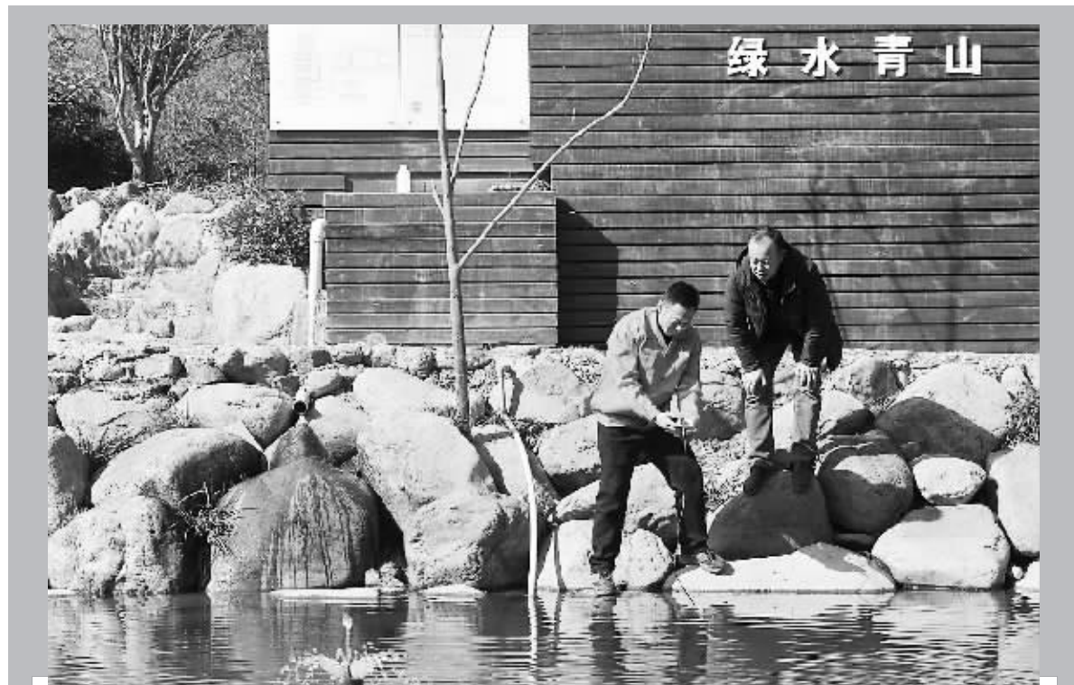
为了防止生活污水污染环境,近年来,天目山镇与临安正清环保合作,对镇域128个生活污水处理终端开展运维、水质检测等工作,及时做好农村生活污水的收集处理,确保出水排放达标。图为工作人员在农村污水处理终端检测污水处理后的水质。
