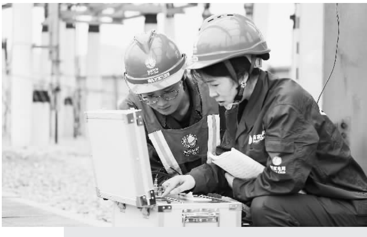
夏季用电高峰即将到来,国家电网四川广安供电公司高压分公司组织专业队伍,对广安电网邻水片区最重要的枢纽站220千伏范家湾变电站开展集中检修,确保人民群众生产生活安全用电。图为5月18日,国家电网四川广安供电公司高压分公司在邻水220千伏范家湾变电站开展集中检修。 CNSPHOTO 提供
